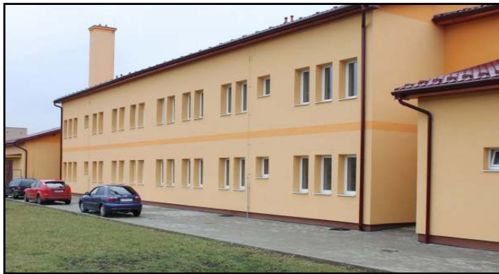
V bytovom dome sa nachádza osem dvojizbových bytov a štyri trojizbové byty. Niektoré sú už užívané. Avšak bez platného kolaudačného rozhodnutia sa byty nesmú užívať. Snímka: L. Krivda
